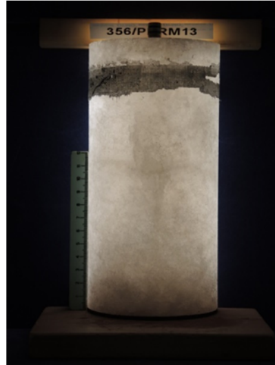
mittig geschädigter Bereich:
