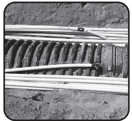
Einfacher Anschluss der Anbindeleitungen mit Heizwendelschweißmuffe
