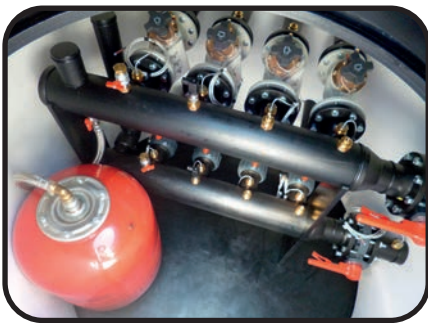
Übergeordneter Haupt-Verteilerschacht
