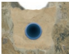
offene Verlegung im Sandbett
