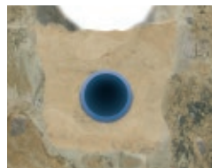
offene Verlegung im Sandbett
