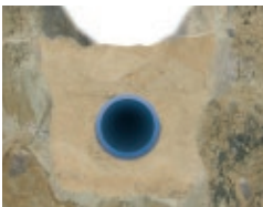
offene Verlegung im Sandbett
