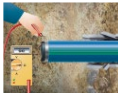
Nachweis auf beschädigungsfreien Einbau nach Verlegung
