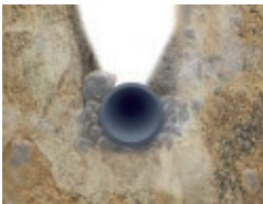
offene Verlegung ohne Sandbett
