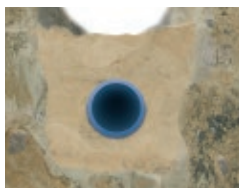
offene Verlegung im Sandbett
