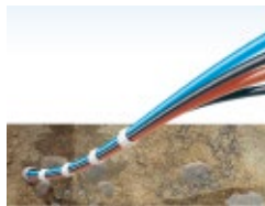
Rohrbündelverlegung mit Abwasser und Trinkwasser in einer Trasse
