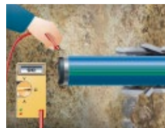
Nachweis auf beschädigungsfreien Einbau nach Verlegung
