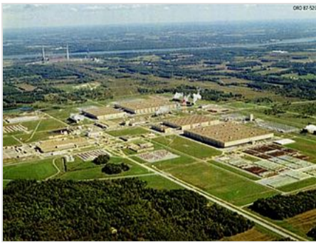
Uranhexafluorid-Lagerplatz in Paducah (USA)
