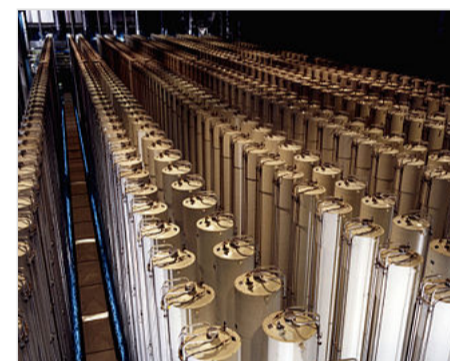
Kaskade von Gaszentrifugen zur Urananreicherung
