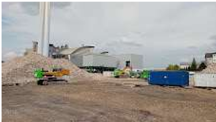
Erweiterung MVA 04_Hagen.jpg 692K
