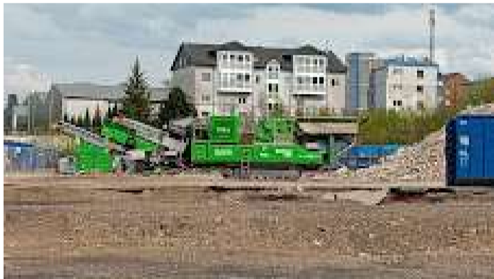
Erweiterung MVA 02_Hagen.jpg 887K
