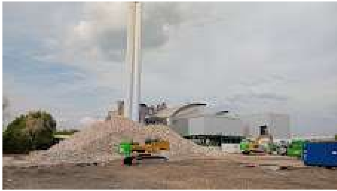
Erweiterung MVA 01_Hagen.jpg 599K
