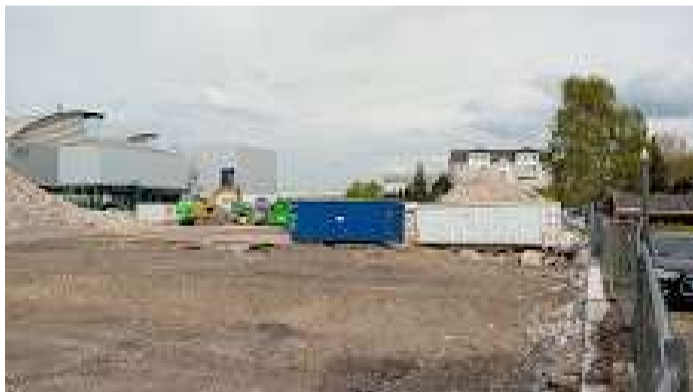
Erweiterung MVA 03_Hagen.jpg 737K
