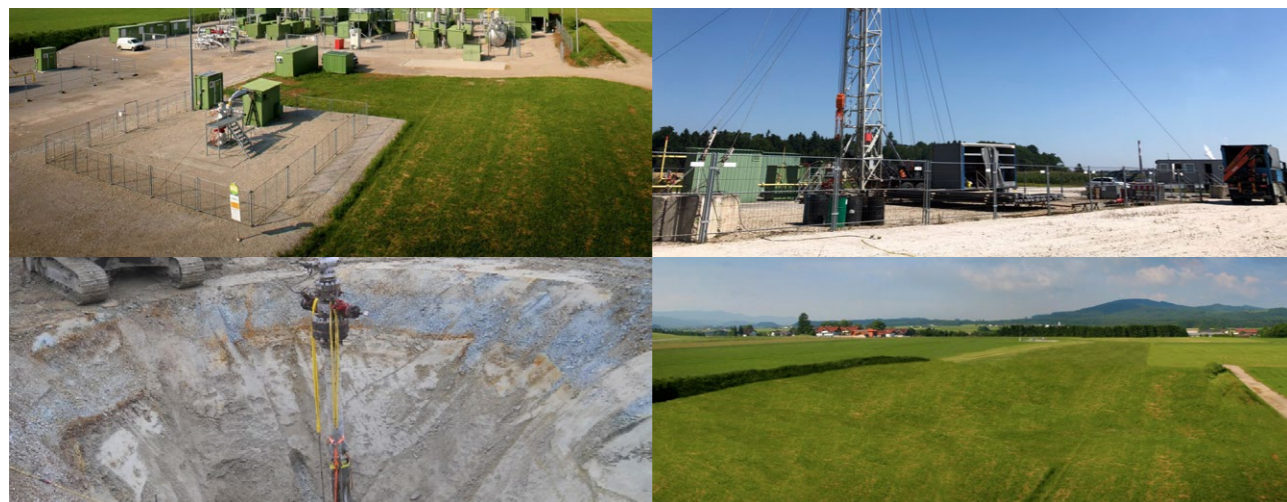
Rückbau aus einer Hand – von der Sonde zur grünen Wiese
