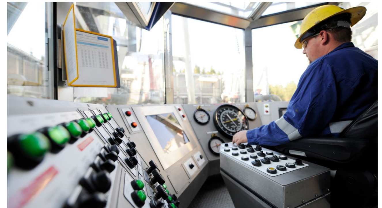
Kranführerstand am Bohrturm
